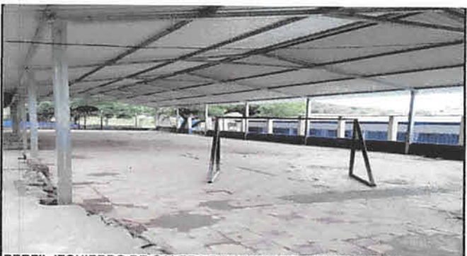
PERFIL IZQUIERDO DE GALERA DE CANCHA DE SUR A NORTE.
